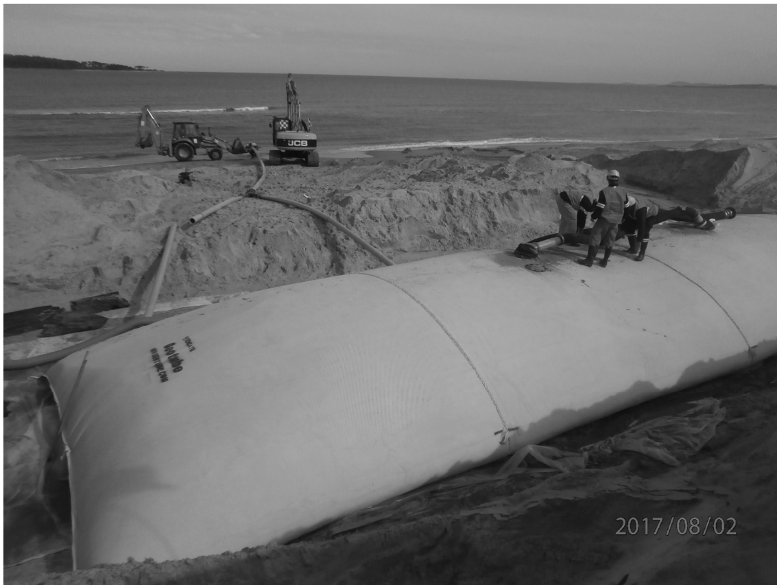
Ilustración 6 Vista de instalación de Geotubos
