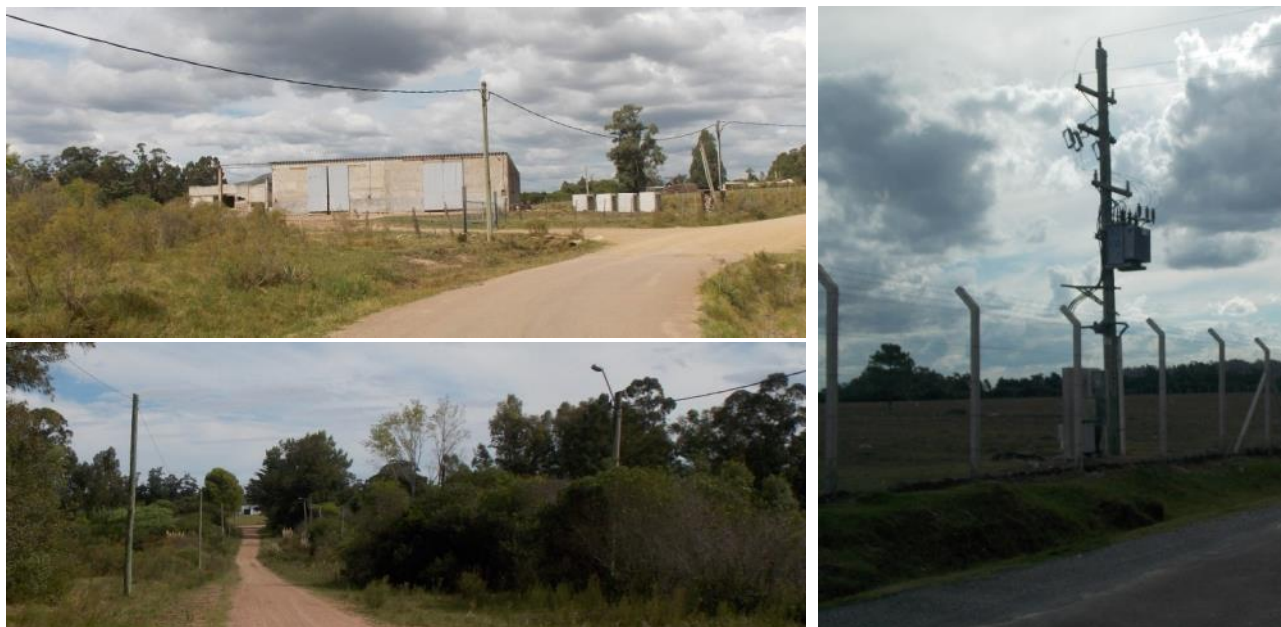
Fig. 18: Tendido eléctrico en el sector.
