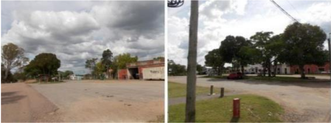
Fig. 22: Localidad Las Flores-Estación
